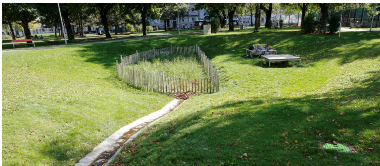
Příklad řešení vsakovacího průlehu:
