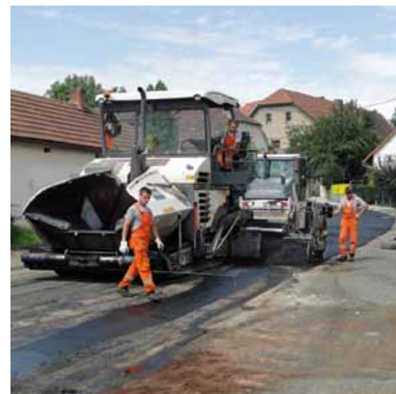
Pokládka první asfaltové vrstvy 6. 8. 2012
