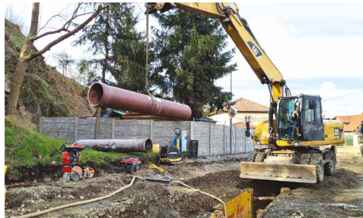
Psárská rarita - výměna nové trubky za novou
