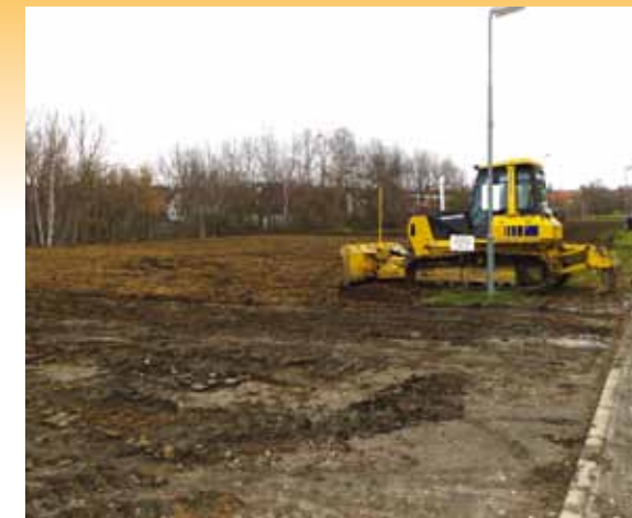
Na sousedním pozemku vedle sportovního areálu zahájili hasiči z SDH Dolní Jirčany terénní úpravy. Po jarním srovnání terénu bude plocha oseta a následně využívána na trénink nejen našich hasičů, ale i malých fotbalistů. Za odvedené práce hasičům moc děkujeme
