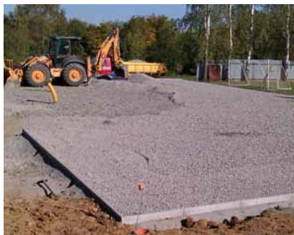
Původní asfaltový povrch byl odstraněn a poté byla zhotovena zcela nová spodní stavba pro umělý povrch (říjen 2012)
