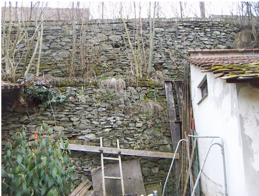
Pohled na střední část opěrné stěny, zahradní domek přechází opět na opěrnou stěnu.
