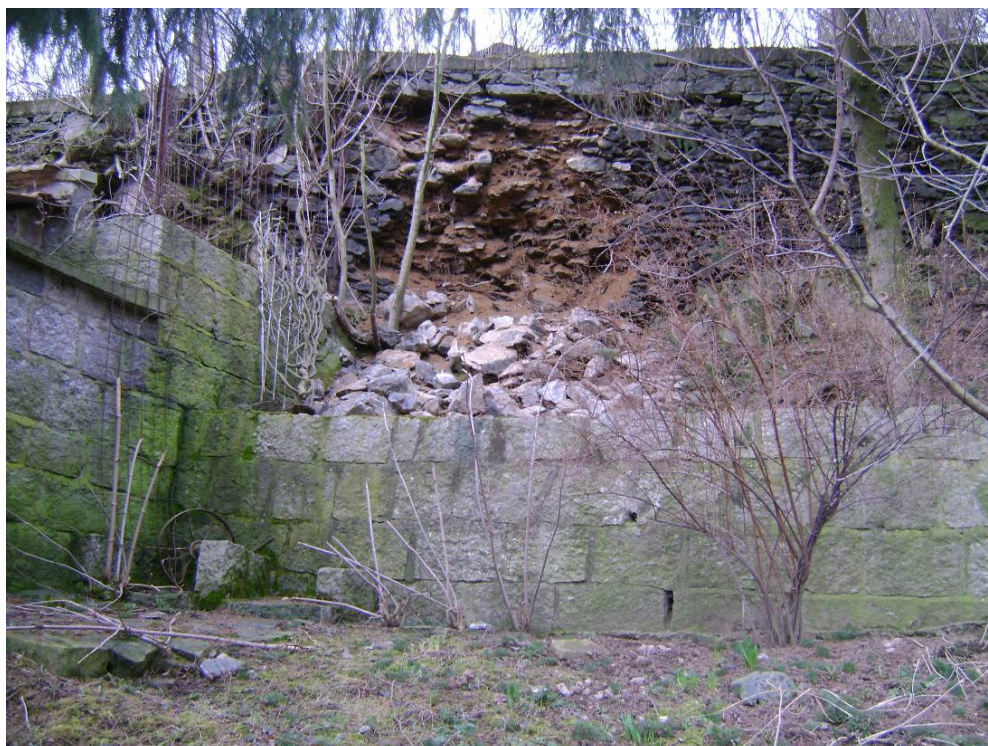
Pohled na vysypanou nejvyšší část, spodní opěrná stěna z žulových kvádrů přechází do zahradního domku.
