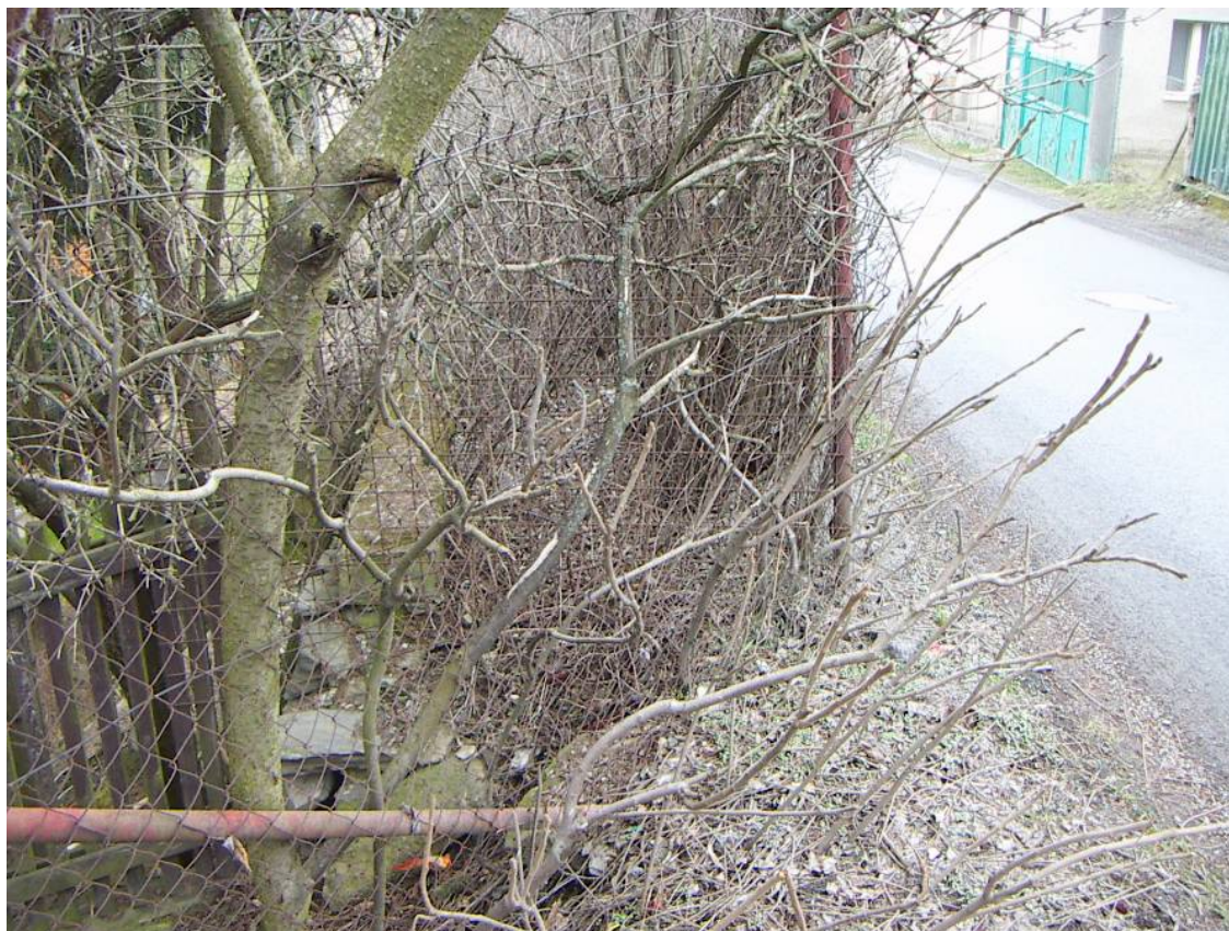
Pohled na jižní zhlaví opěrné stěny z komunikace
