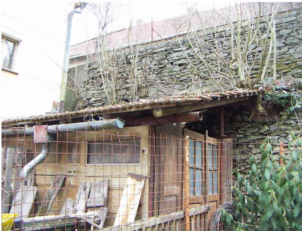
Pohled na severní část dvoustupňové opěrné stěny na sousedním pozemku přecházející do betonové stěny.
