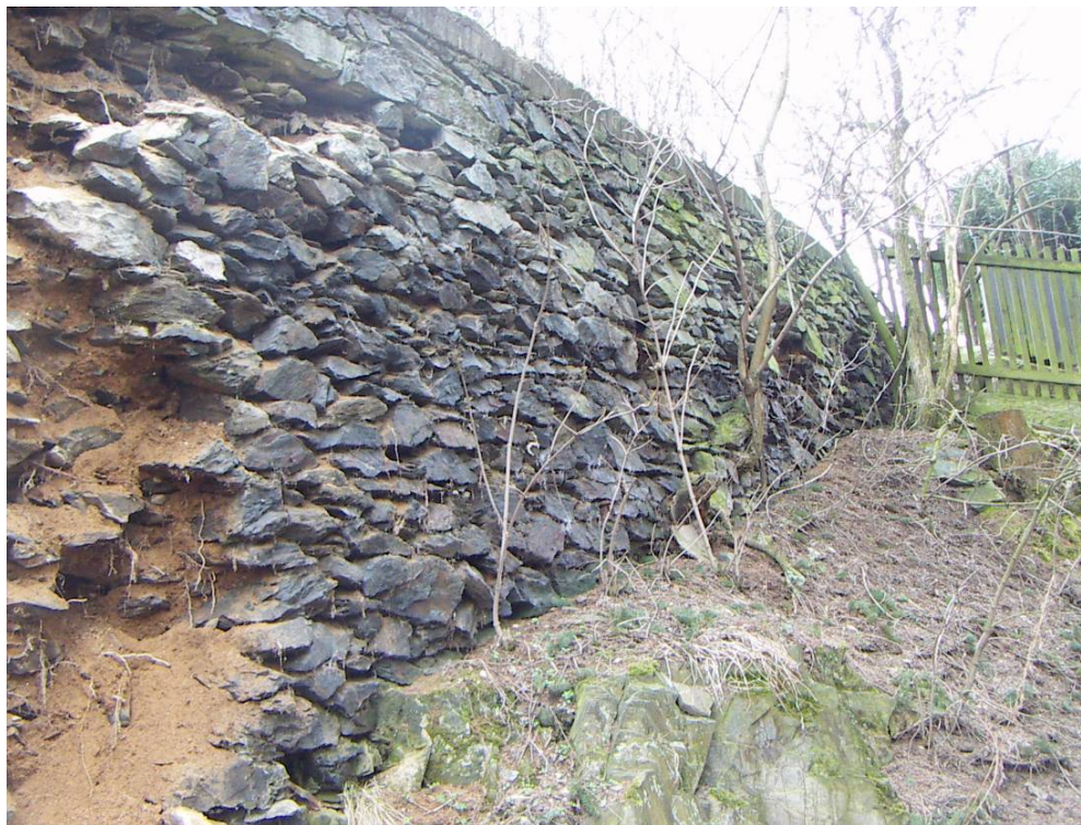
Pohled na jižní část opěrné stěny
